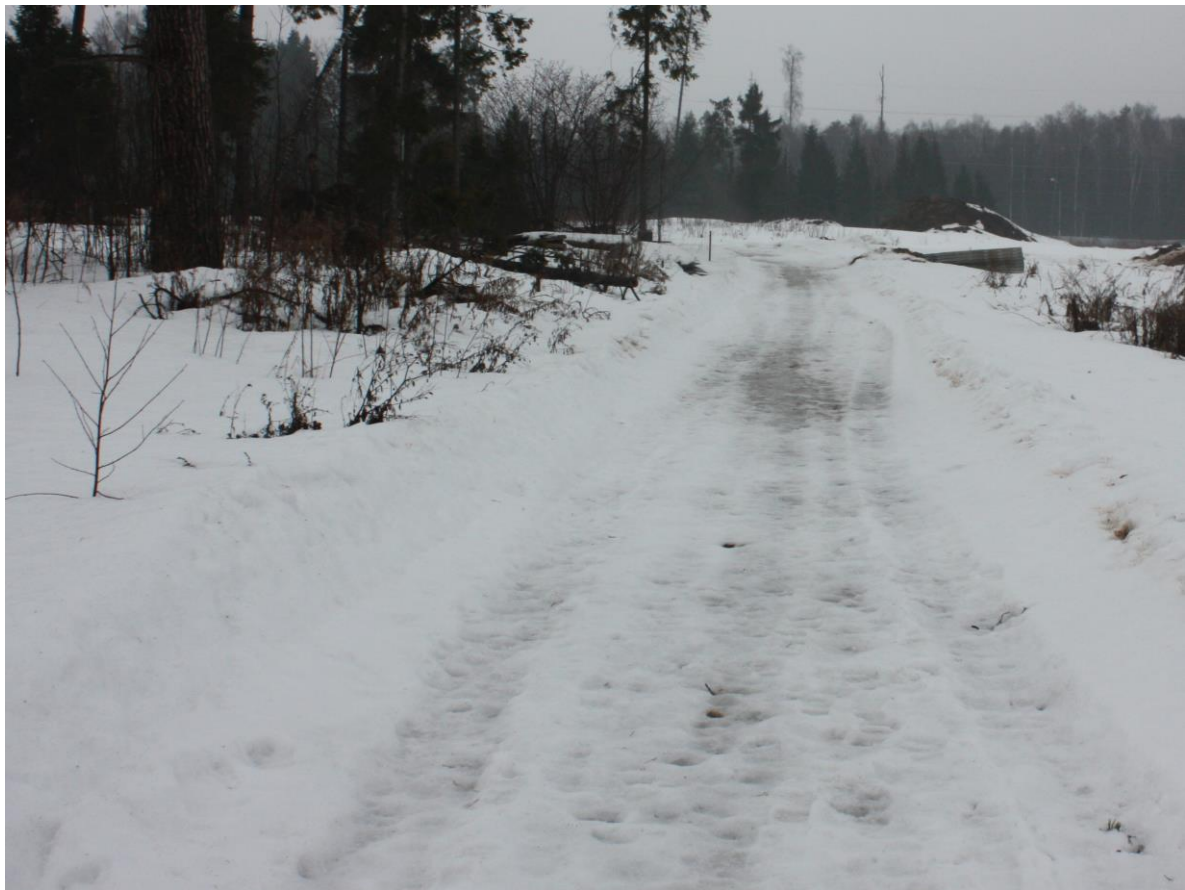
Рис. 3.1.2. Общий вид временной дороги
